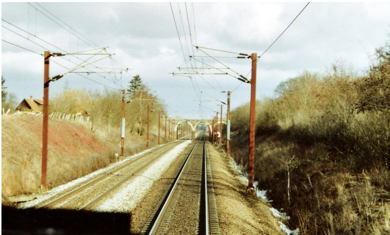
Så er det Viby Sjælland (det sidste var vigtigt at huske, når noget skulle sendes hertil, for der findes også en Viby Jylland, men det er også historie i dag). Foran mig står den ene af de to tilbageværende "Englænder broer". De blev bygget da banen mellem Roskilde og Korsør blev anlagt i 1856. Det er let at se, at det er den oprindelige tracé, jeg kører på, Strækningen blev dobbeltsporet i 1903. Det er også nemt at se den sporsænkning ved broen, der var nødvendig da strækningen fik "LUFTLEDNINGER" i sidste halvdel af 80'erne.
