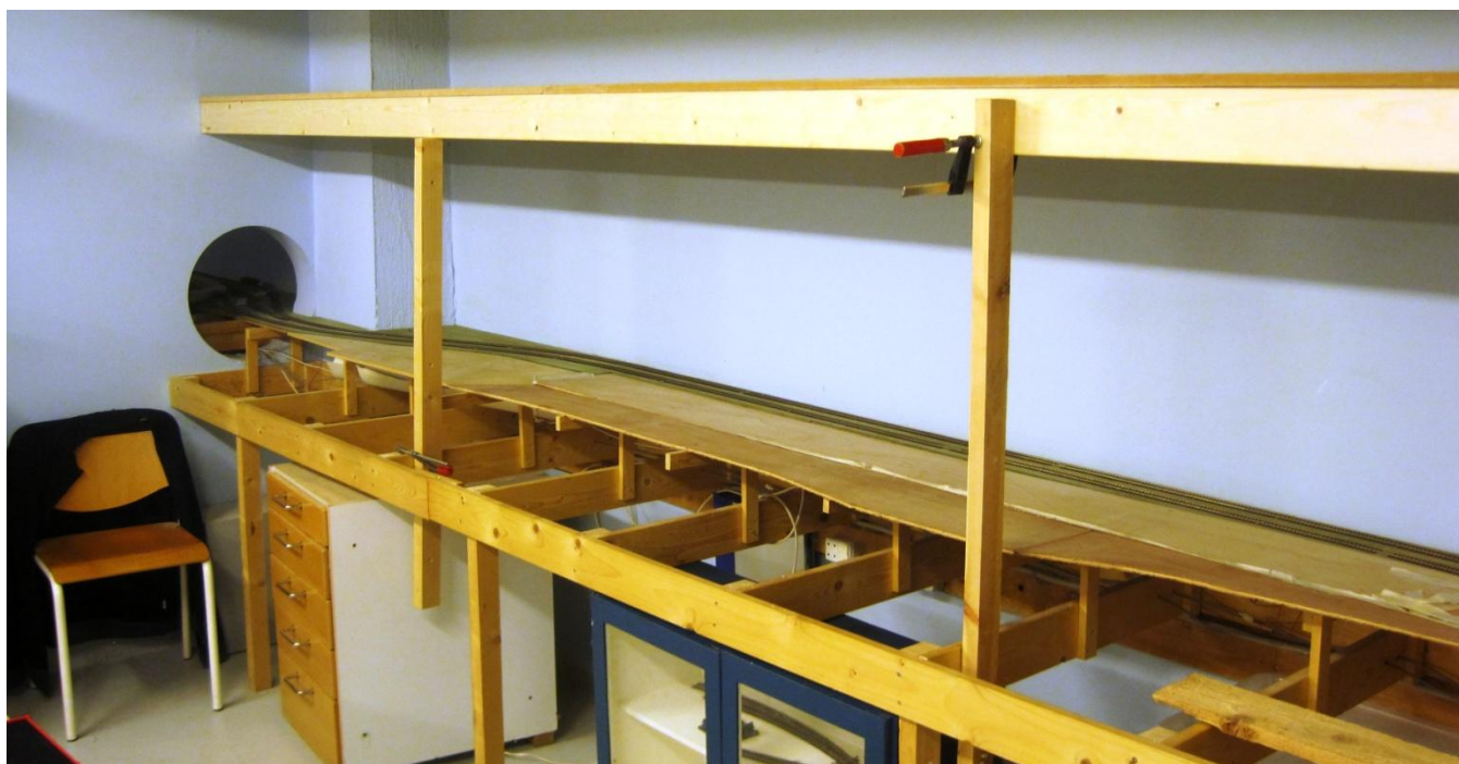
Så langt nåede vi d. 16.01. De to lægter er kun midlertidige og fjernes, når ophænget er lavet. Det skal være solidt, for vores fjernsyn og film skal stå på hylden.
