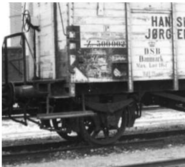
ZF 500 002. Her viser hjørnemærkerne, to firkantede og en med spids, at vognen er udstyret med en ikke internationalt godkendt, trykluftbremse, der kan køre i G som P bremse. Billedet er taget i Aarhus 1955 af Poul Egon Clausen. Arkiv.: DMJK.
