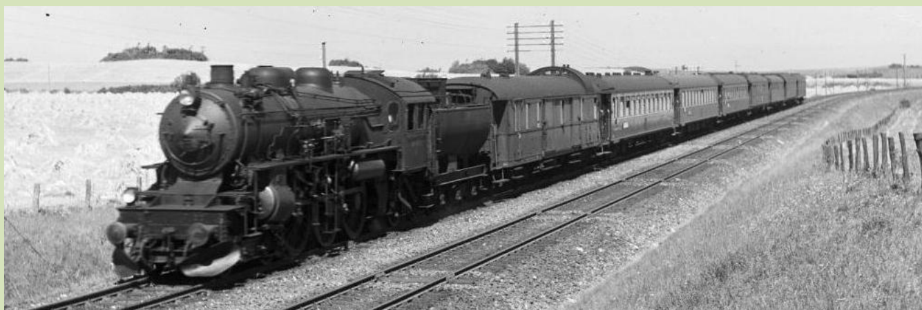
E 983 med tog 36 Nord Express i august 1952. Billedet er taget lige uden for Korsør omtrent der hvor motorvejen i dag krydser jernbanen. Rejsegodsvognen har en fornem fortid, idet de var lavet specielt til de fine Rheingold tog DR Spw4ü-28. Herefter følger hele 3 CIWL sovevogne, type Y, herefter 3 siddevogne og til sidst en enlig sovevogn. Foto.: Københavns Foto Service. Arkiv.: Danmarks Jernbane Museum.
