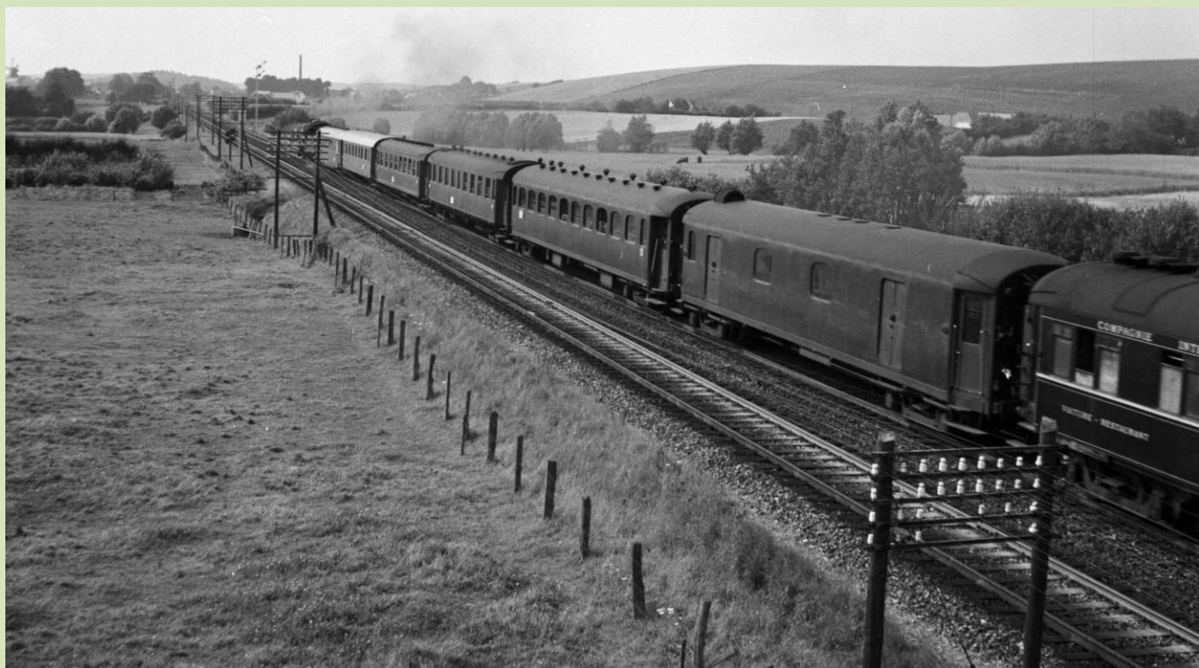
R 963 med Paris Express, tog 47 ved Bred på vej mod Padborg 1952. Togets oprangering er vældig interessant, bagfra er det WR 4045, Rapide nord bagagevogn, Rapide nord 3 klasse, DSB CA 1001 -1024, CC vogn, DB? og til sidst en DB "Schürzenwagen" C4ü-36a, lige efter maskinen. Et fint tog på bare 7 vogne.
